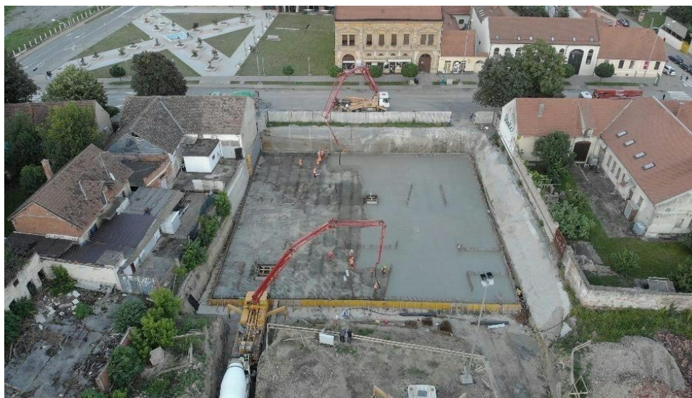
Slika 1. Izlijevanje temeljne betonske ploče
